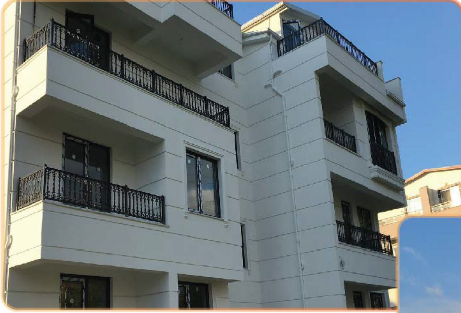
FRANSIZ BALKON UYGULAMASI
